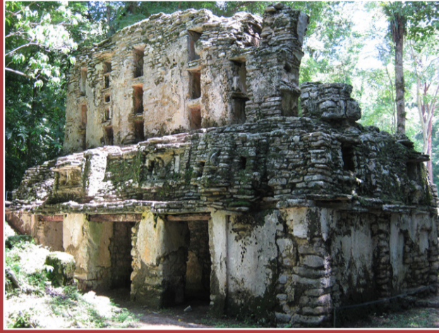
Edificio 6 de Yaxchilán, Chiapas
