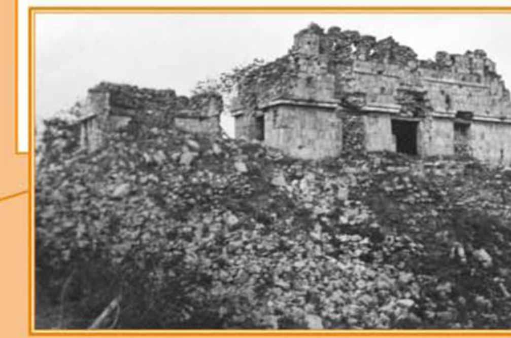
Edificio Poniente del Cuadrángulo del Cementerio, estado de conservación antes de su restauración. © Archivo Técnico de la CNA
