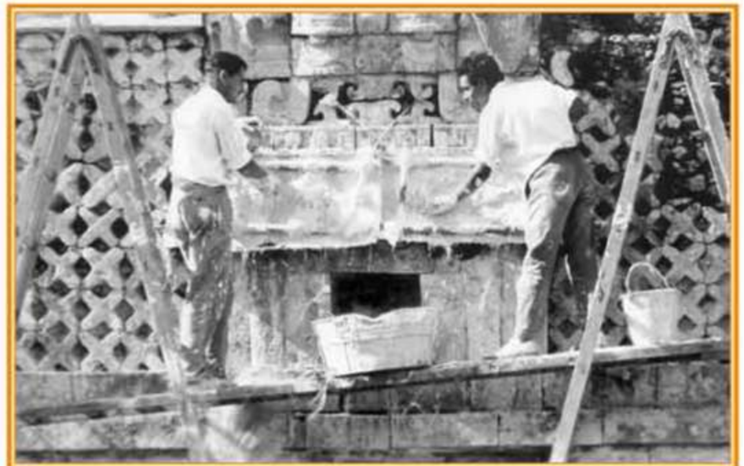
Cuadrángulo de las Monjas, Edificio Sur, proceso de obtención de un molde de los detalles de la choza maya que se localiza en el friso norte, 1930. © Archivo Técnico de la CNA
