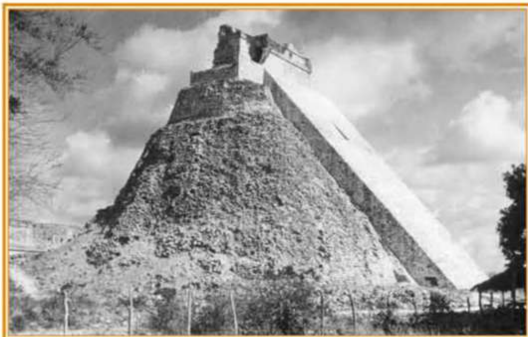
El Templo del Adivino, imagen que muestra el costado sur y la escalinata oriente después de la restauración. © Archivo Técnico de la CNA
