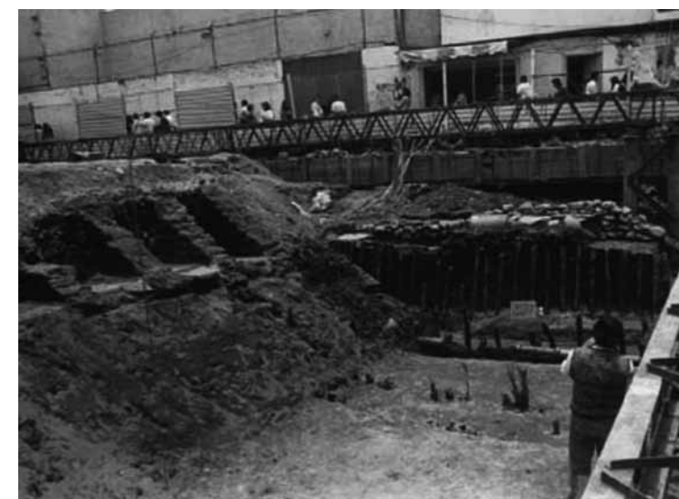
Acequia del Tezontlali y drenajes porfirianos, localizados sobre Eje 1 Norte entre las calles de Brasil y Florida
