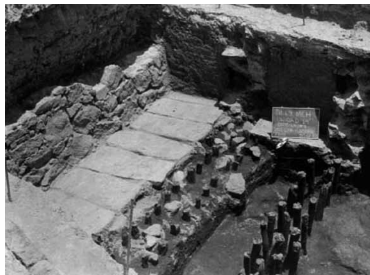
Sistema constructivo de drenajes localizados en la construcción de la línea 9 del Metr
