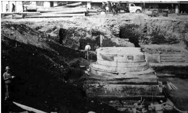
Excavaciones realizadas en la estación Pino Suárez
